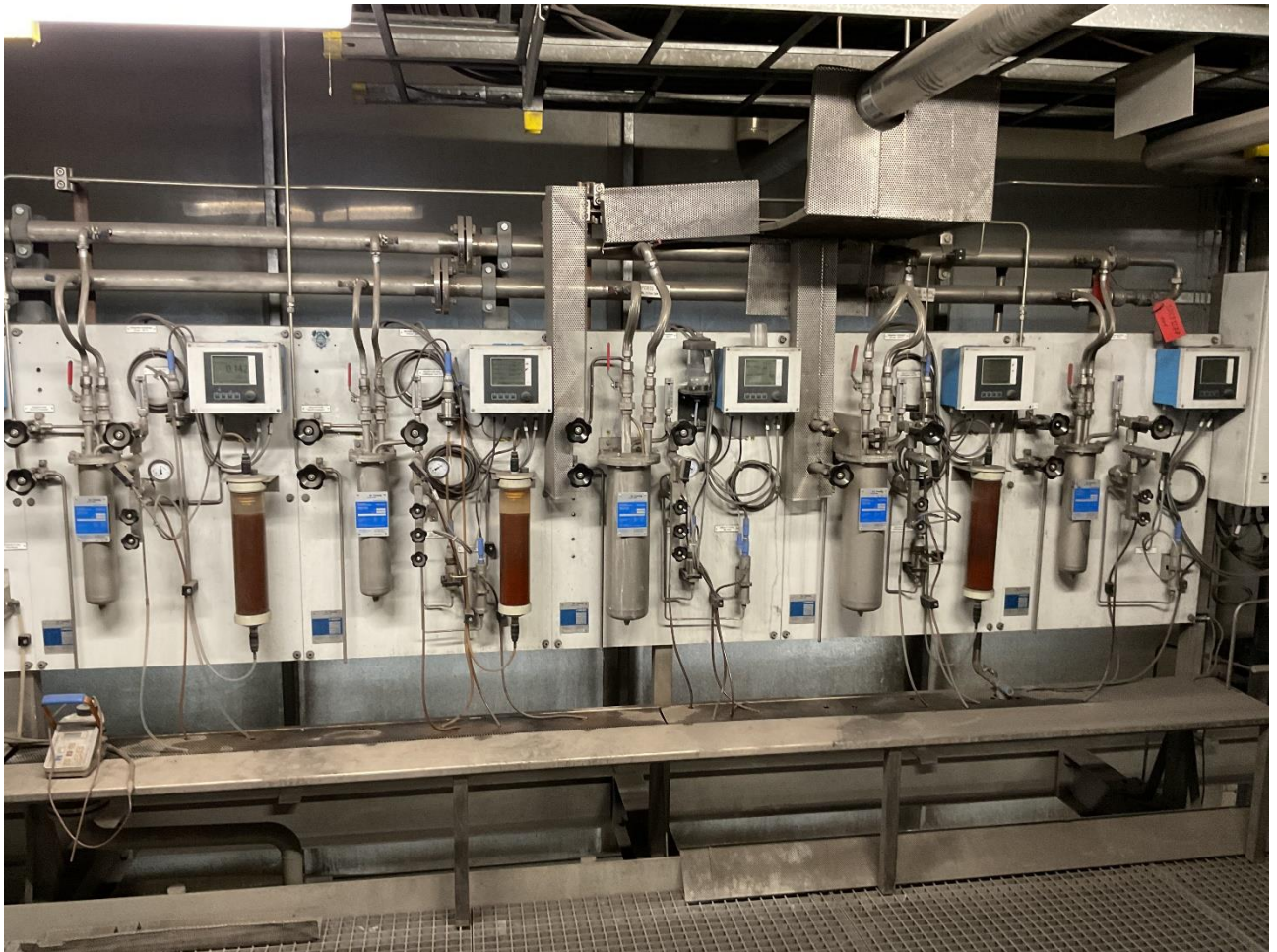
Abbildung 4: Aufbau Wasseranalysen Linie 3
